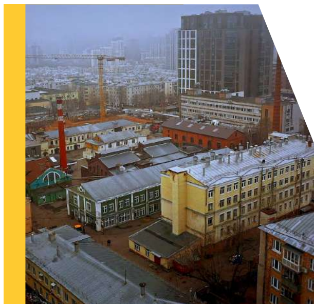
Работы подготовительного периода по сносу строений в рамках строительства ЖК «Lucky»
