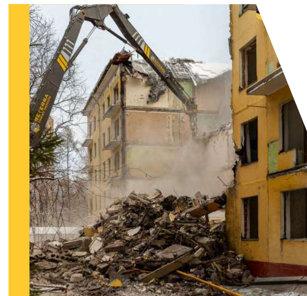
Комплекс демонтажных работ существующих зданий и сооружений с подземной автостоянкой в рамках выполнения программы реновации города Москвы
