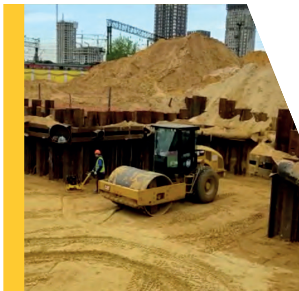
Комплекс работ по консервации объекта включая водопонижение на ул. Дербеневская, вл. 20
